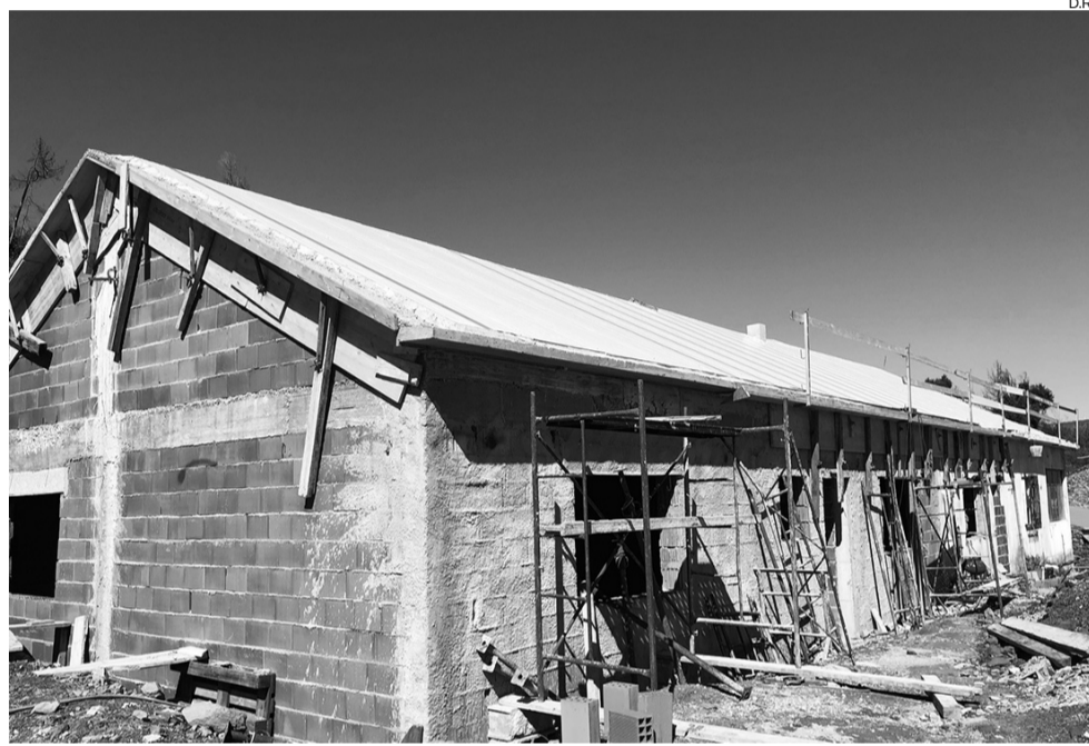
Casa já sofreu obras de reabilitação e ampliação, mas ainda muito há a fazer
